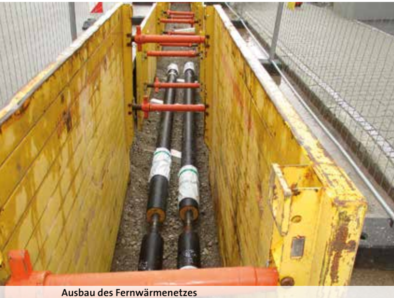
Ausbau des Fernwärmenetzes
