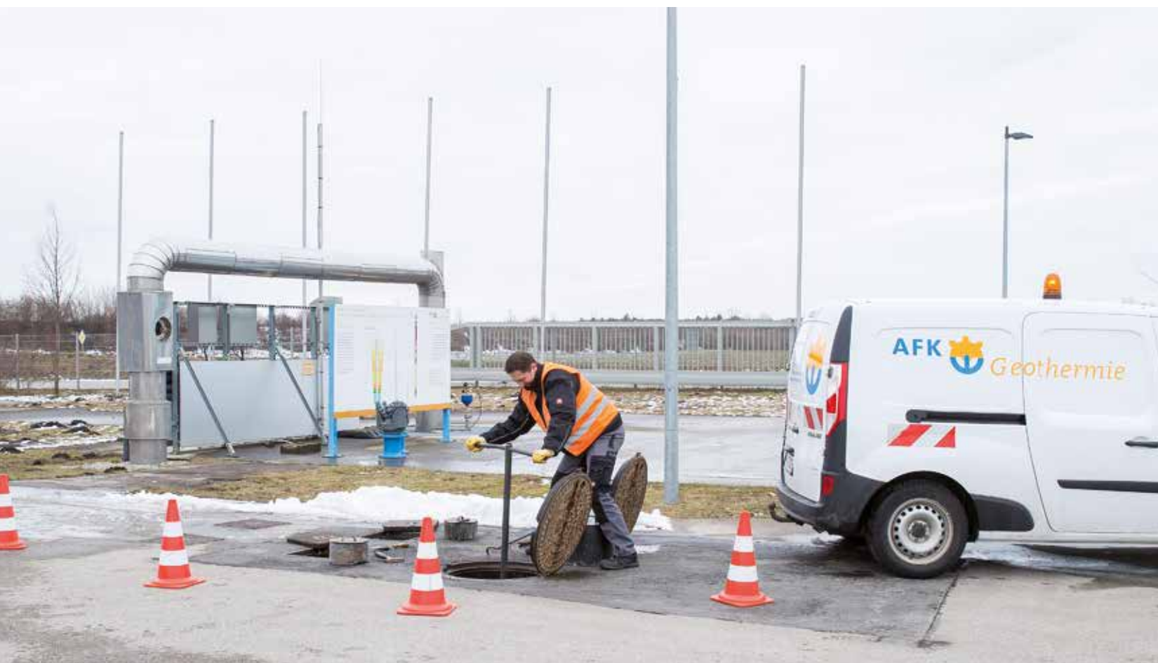
Wartung der Absperrungen und Entlüftungen im Fernwärmenetz.
