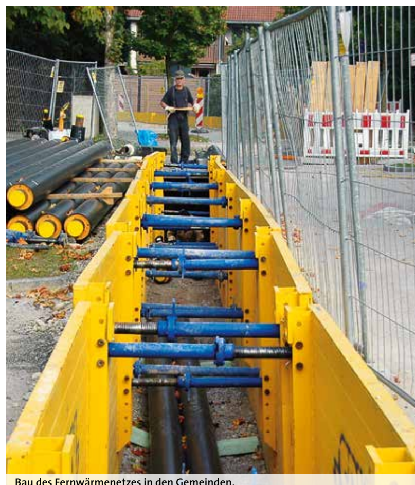
Bau des Fernwärmenetzes in den Gemeinden.
