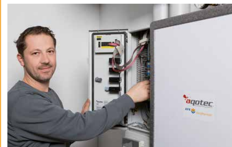
Techniker der AFK bei der Wartung einer Übergabestation.
