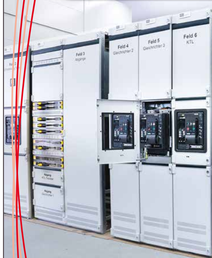
Schaltanlagenbau bei der Josef Weiß Elektrotechnik.
